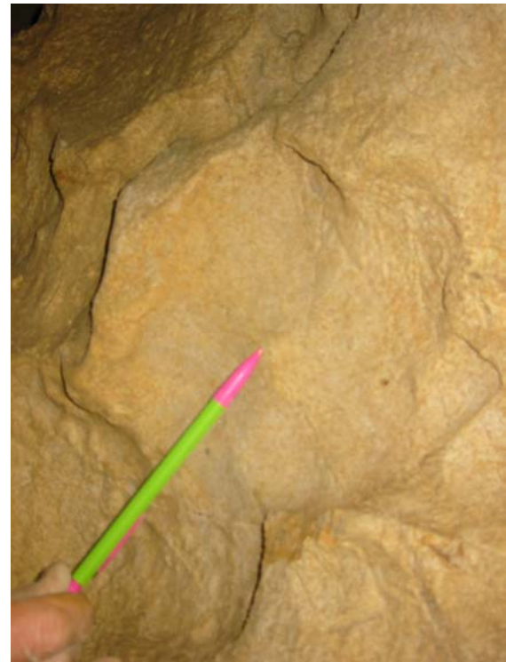
Fig. 47 : coalescence de poches de corrosion attestée par un « hum » central (Photo J-C d'A-N)
